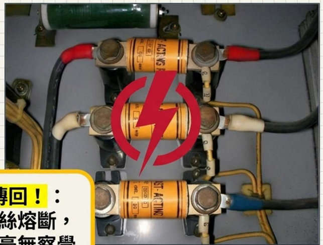
隱形的斷點：直流充電機盤 (460VAC/110VDC) 保險絲熔斷
