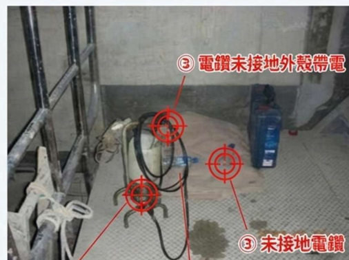
① 水管廊內潮濕地面 ② 電纜暴露有破皮風險 ③ 未接地電鑽
