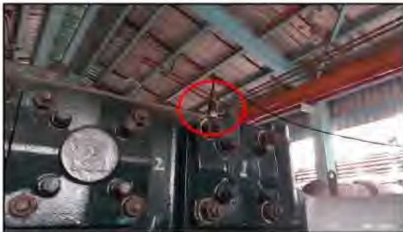
加速規安裝位置
